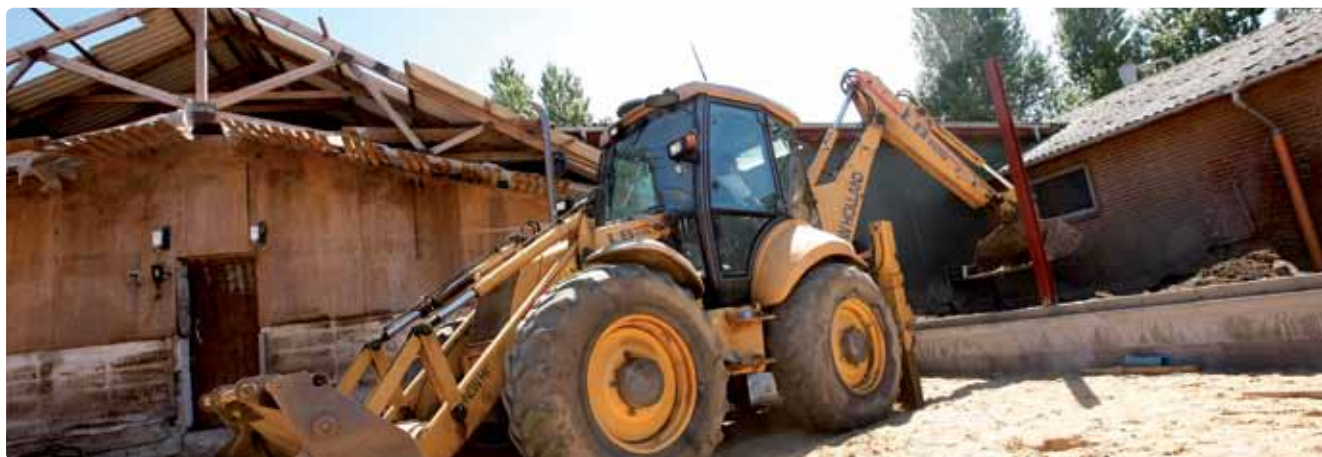
Byggeriet af den nye stald er i fuld gang.
